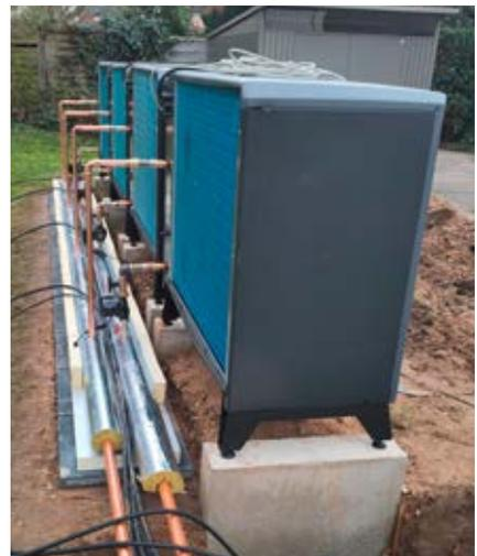
Es wurde ein Verbund von vier Luft-Wärme-Pumpen aufgebaut, der im Wechsel die einzelnen Pumpen bedarfsweise auf-
